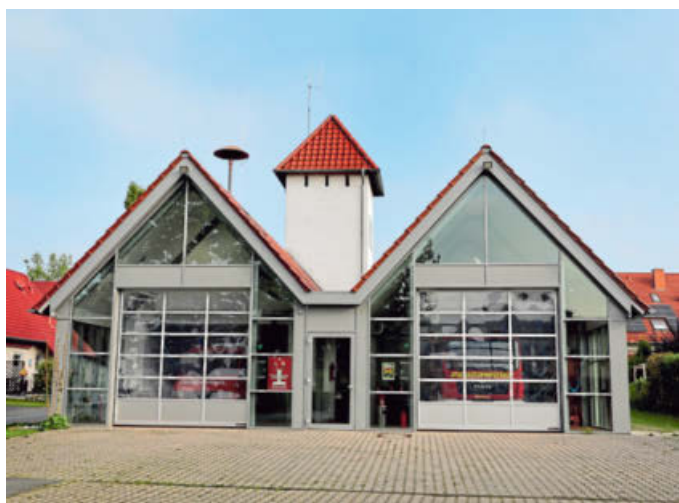
In Pödinghausen ist es gelungen, den Schlauchturm als Teil eines ausgebauten Feuerwehrhauses zu erhalten. Foto: Kiel-Steinkamp
