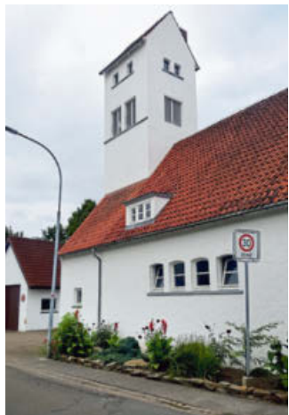
Das Spritzenhaus Südlengern steht unter Denkmalschutz.
