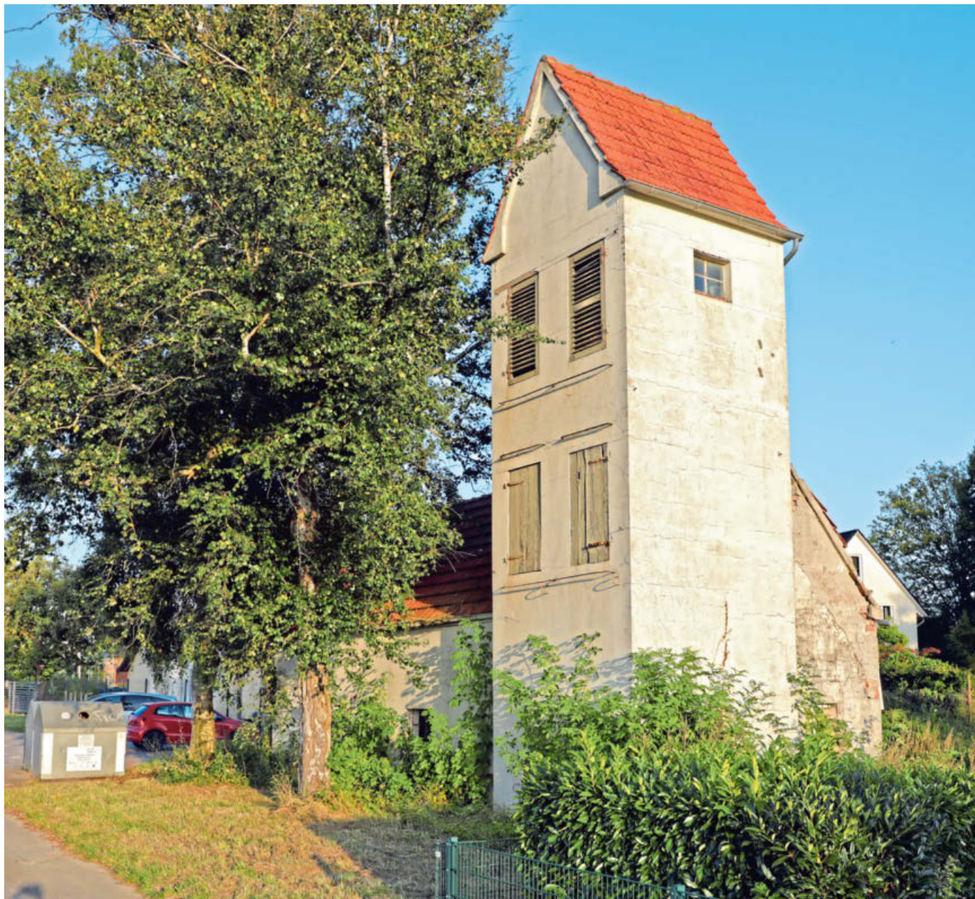
Das frühere Spritzenhaus in Lenzinghausen ist seit langen Jahren ungenutzt. Der Schlauchturm hat die typischen Lüftungsclappen. Foto: Kiel-Steinkamp
