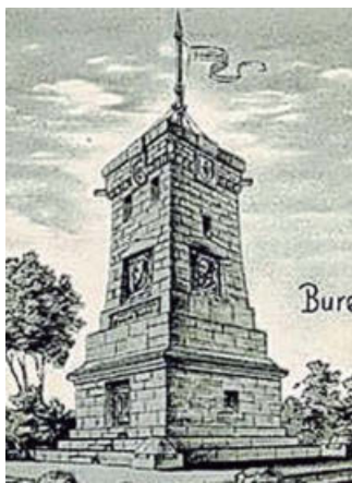
Darstellung eines in Enger geplanten, jedoch nie umgesetzten Buren-Denkmal.
