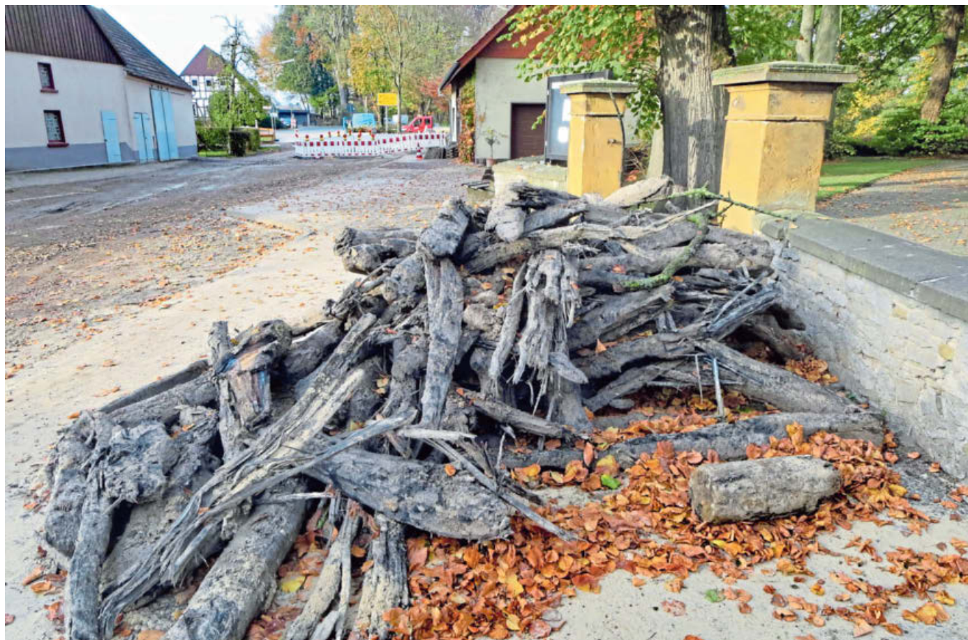
Die ausgebaggerten Hölzer des Bohlenweges liegen auf einem Haufen an der Mauer der Wallenbrücker Kirche.
