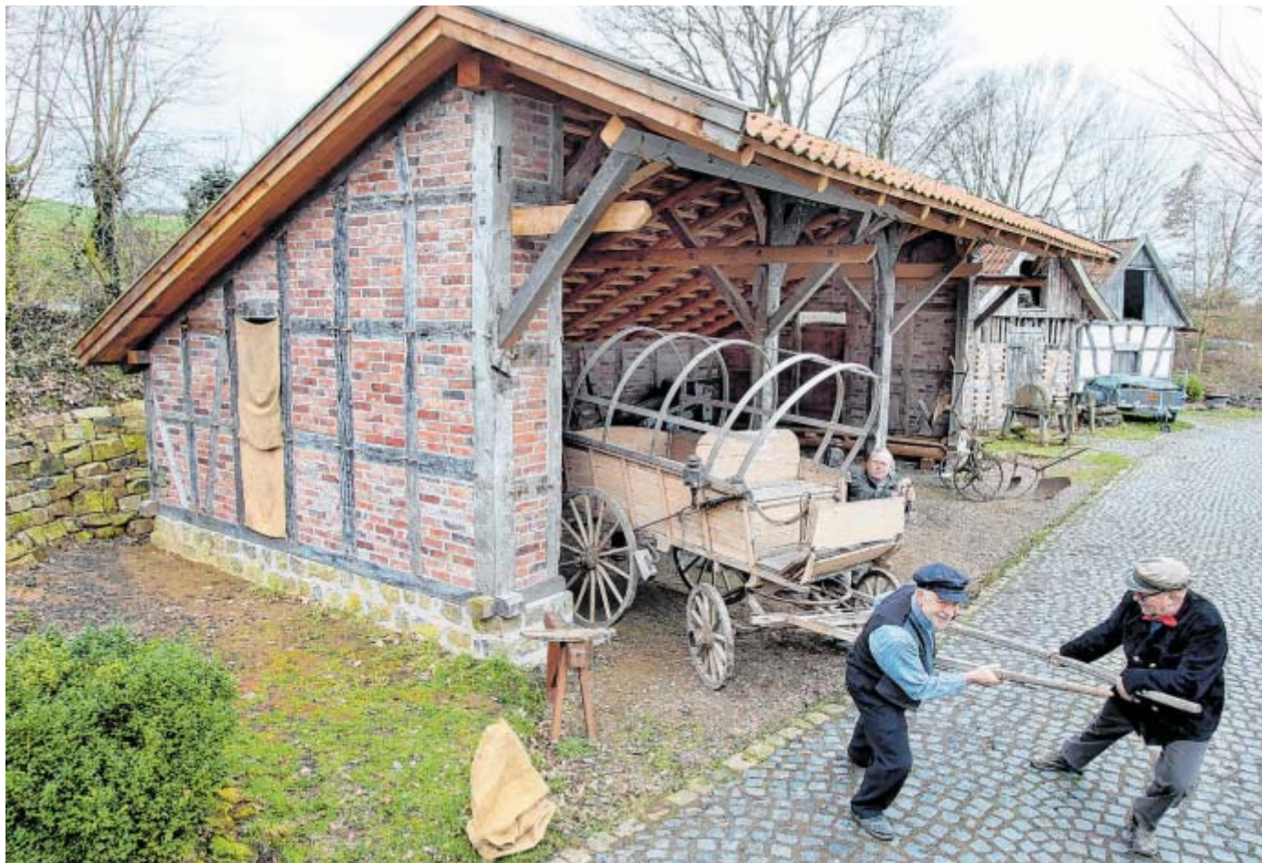
Unter Dach und Fach: Wilfried Quest, Ulrich Flachmann und Wilhelm Backs (hinten) bugsieren den Federwagen an seinen neuen Stellplatz. Die neue Remise steht jetzt in einer Reihe mit dem Backhaus und dem Haus für den Brennholzvorrat. FOTOS: FRANK-MICHAEL KIEL-STEINKAMP
