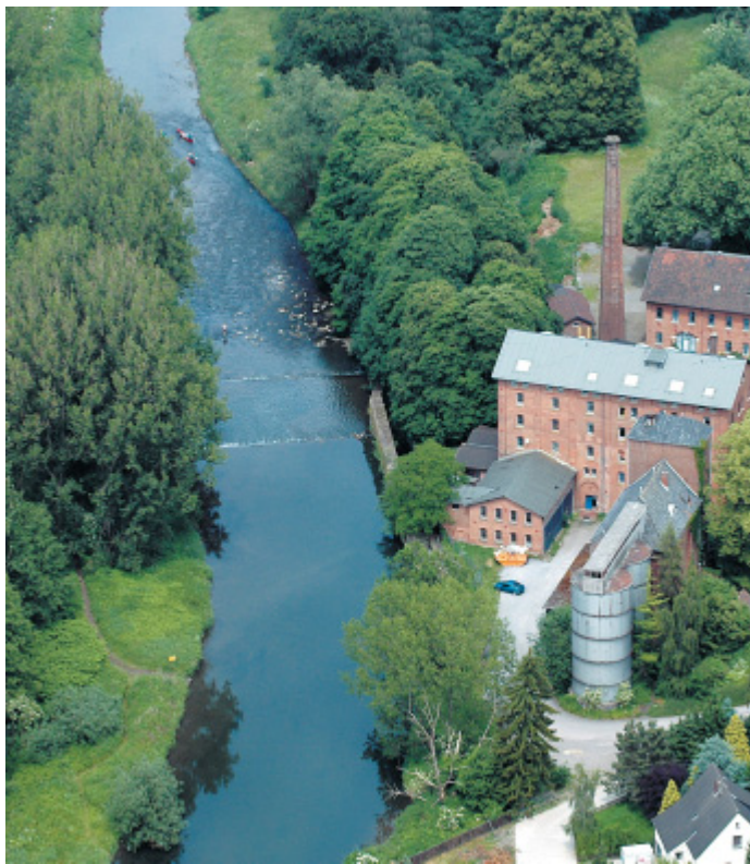
Angetrieben: Mit der Kraft der fließenden Werre lief das Mühlenwerk Kießler in Löhne. Zwei Turbinen lieferten 80 Kilowatt.
