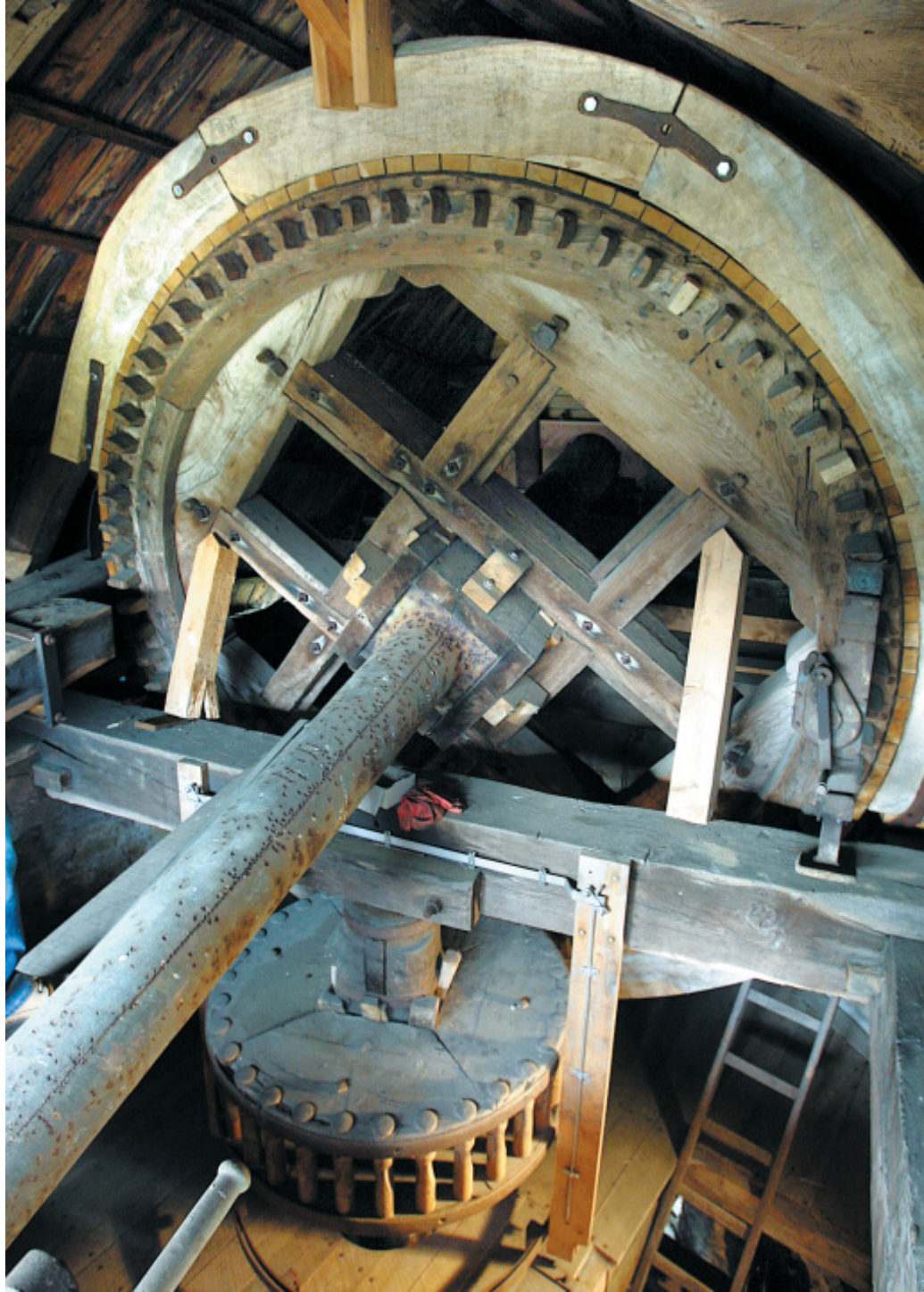
Kammrad, Bunkler, Flügelwelle: Die Innenansicht der Windmühlencappe - eine Welt von Kraft und Bewegung. 204 Jahre lang hat es funktioniert.
