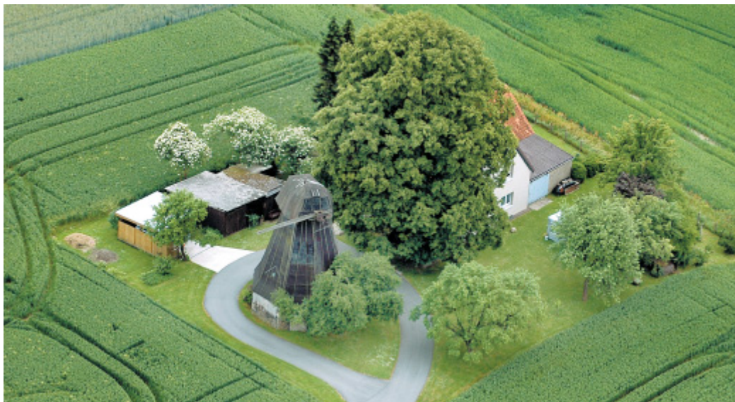
Aus Holz: Schürmanns Windmühle in Enger-Dreyen besteht aus einem achteckigen Holz-Gehäuse auf einem steinernen Sockel. Für elektrischen Antrieb umgebaut, ist sie noch heute mahlfähig.
