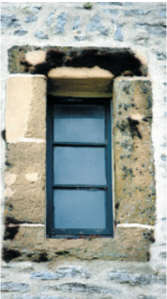
Laibung: Königsmühlen haben aufwändig gebaute Fenster.
