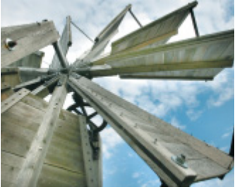
Windrose: Dreht die Kappe automatisch in den Wind.
