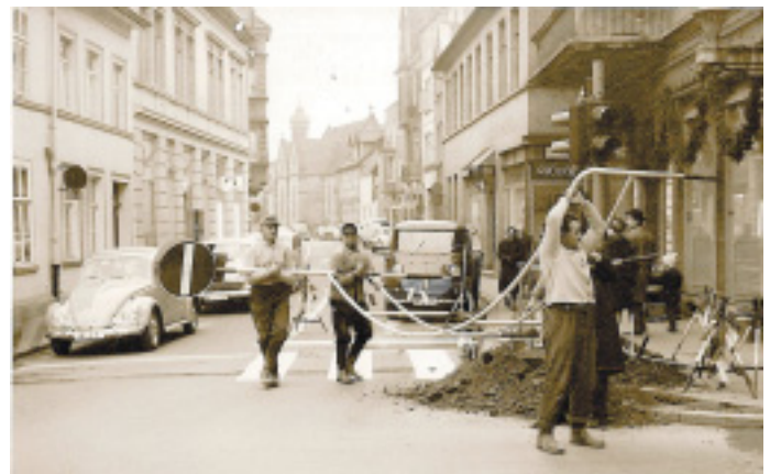
Straßenbau in der Komturstraße: „Wolff“ steht über dem Schaufenster von Haus Nr. 22 (links hinter der Ampel, Blick vom Neuen Markt).
