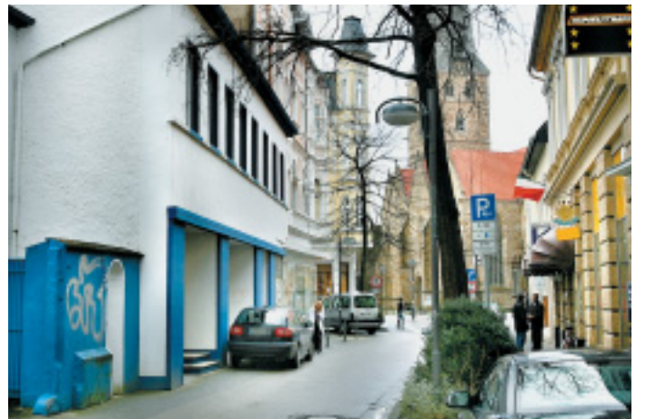
Blauer Schaufensterrahmen: Das Geschäftshaus heute von gleicher Stelle wie oben. Der Neubauantrag ist gestellt.
