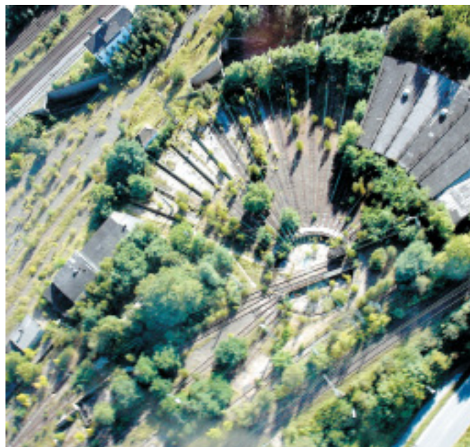
Die Drehscheibe: Links ist das Dach der Kantine zu sehen, daneben die beiden Gleise, auf denen die Viehwaggons standen.
