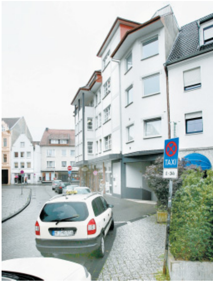
Das Rauchereck heute: Eingang in die Tiefgarage.
