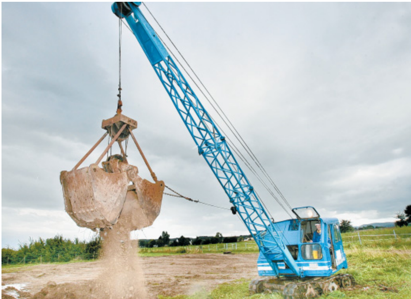
Seilbagger: Die ganze Aufmerksamkeit des Baggerführers gehört den Seilen. Von ihnen hängt alles ab. Sie müssen sauberlich auf und ab gewickelt werden und ständig unter Spannung sein.
