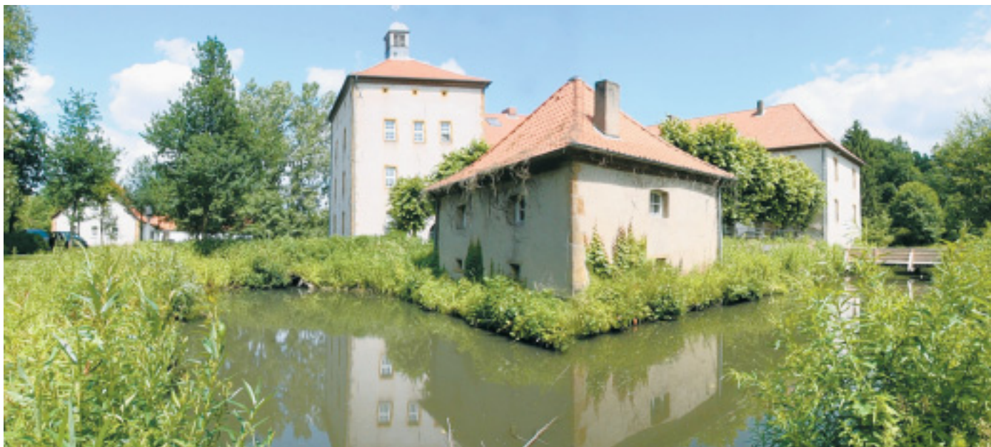
Gut Bustedt von Süden: Eine Gräfte (der Burggraben) umschließt den Gebäudekomplex seit alter Zeit. Alles begann mit einer Niederlage des Spenger Ritters Heinrich von Ledebur.
