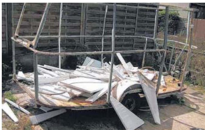
Stahlrohrkäfig: Um das Gerüst herum wird der Wohnwagen neu aufgebaut.
