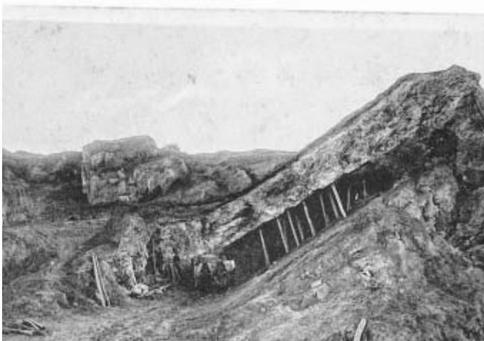
Bergbau: Wie bei der Suche nach Kohle wurden Stollen in den Hang gegraben.
