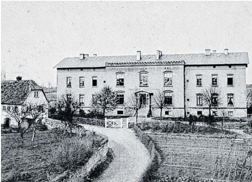
Friedrich Wilhelm Hospital: Das Krankenhaus wurde 1858 eröffnet. Heute ist in einem Nachfolgebau „Auf der Freiheit“ das Technische Rathaus der Stadt Herford untergebracht. FOTO: KOMMUNALARCHIV
