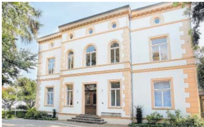
Prachtbau: Die Villa Schönfeld ist frisch renoviert.
