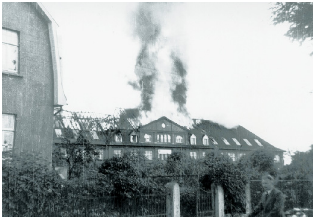
Lacke und Farben brennen gut: Der gesamte Dachstuhl, in dem sich die Lackiererei der Möbelfabrik befand, wurde ein Raub der Flammen.
