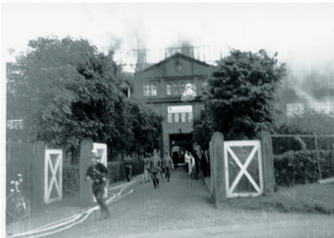
Schläuche ohne Ende: Im Laufschrift legten die Feuerwehrleute ihre Leitungen durch die Haupteinfahrt zum Brandherd.
