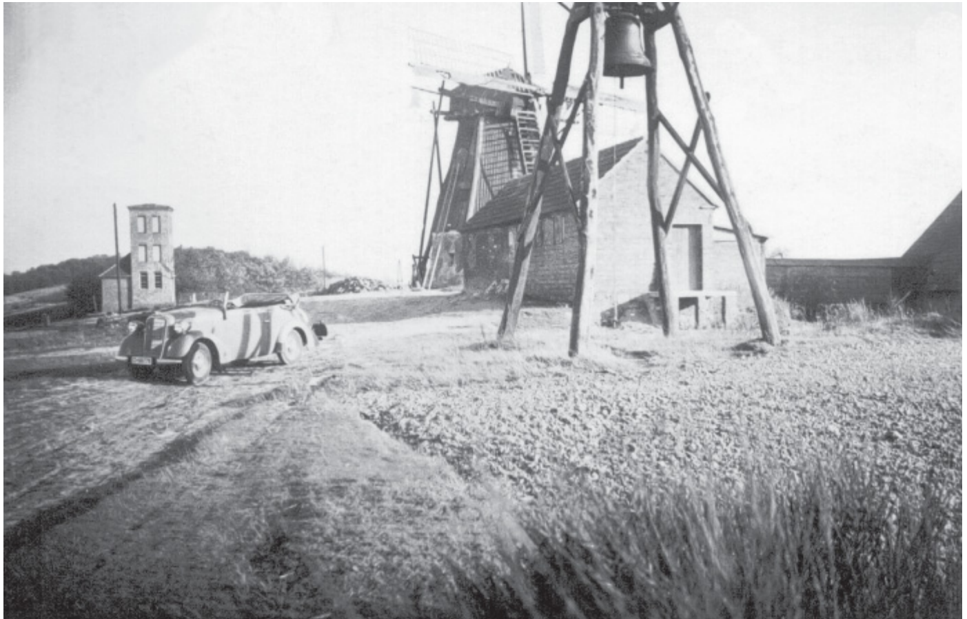
Glockenturm, Mühle, Spritzenhaus: Der Schlauchturm (links) an der heutigen Senderstraße war lange Zeit ein Wahrzeichen Schwarzenmoors neben Schröders Windmühle. Das Foto entstand um 1932. Bis 1973 stand er dort.
