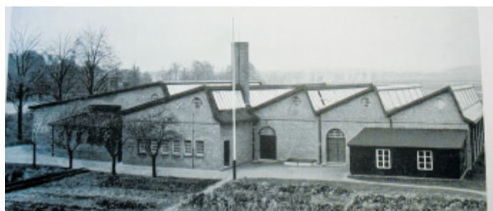
Die neue Fabrik: Das Licht fällt von oben durch die Glasdächer. Hier ist Platz für 50 Webstühle. Die Halle stand an der Lübbecke Straße.
