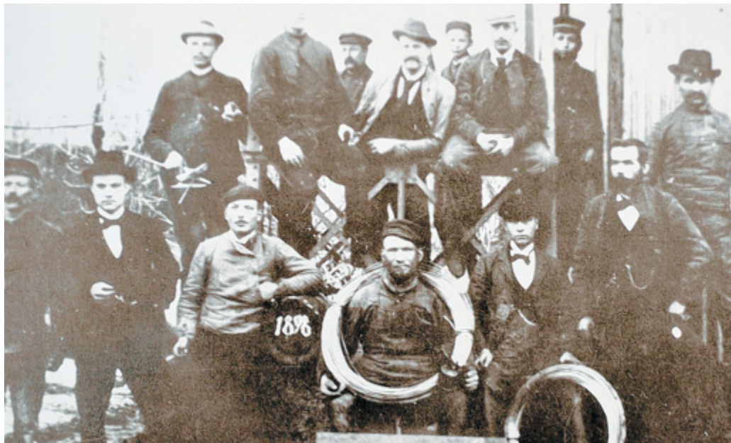
Kabelmannschaft: Die Männer von der Wassermühle Riepe setzten Masten und zogen Leitungen kreuz und quer durch Enger.
